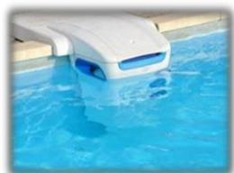
**Système de filtration intégré / Mur filtrant** : Système de filtration intégré en lieu et place d'une partie de la paroi du bassin, constitué d'un compartiment, immergé dans le bassin, contenant skimmer, refoulement(s) filtre, et d'un local technique contigu au bassin contenant notamment la pompe de filtration.
