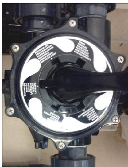
2 - Remettre la pompe en route sur la touche "manu". Laisser le lavage se réaliser pendant 40 sec à 2 min selon l'encrassement du filtre
